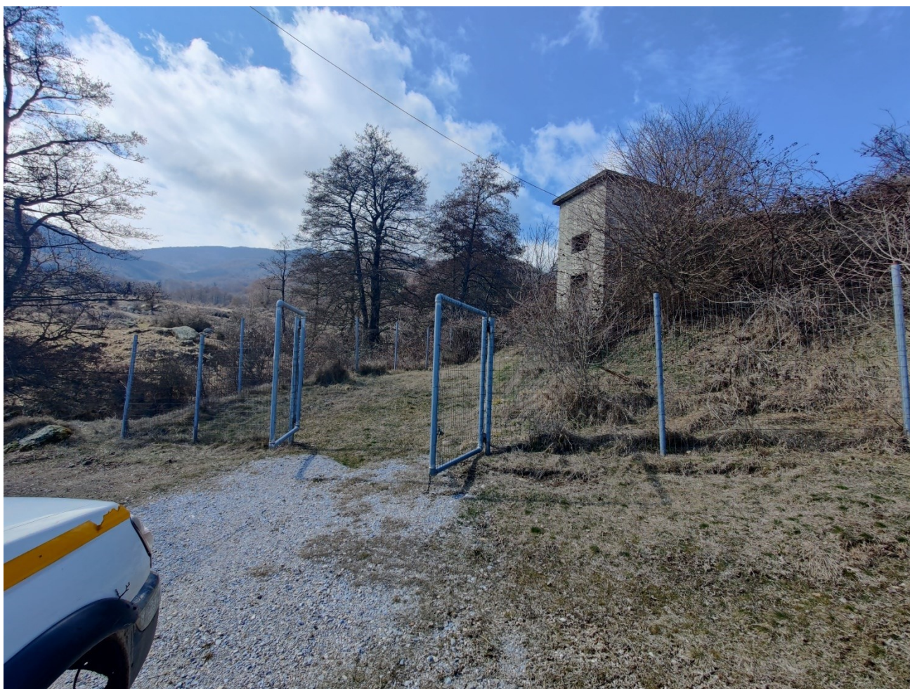
Εικόνα 17: Η δεξαμενή συγκέντρωσης υδάτων στην κοινότητα Περιθωρίου.
