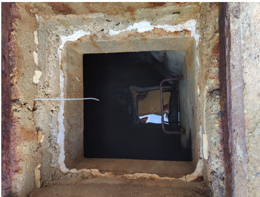
Εικόνα 12: Άποψη εντός της καταπακτής πρόσβασης στη δεξαμενή της κοινότητας Δασωτού.
