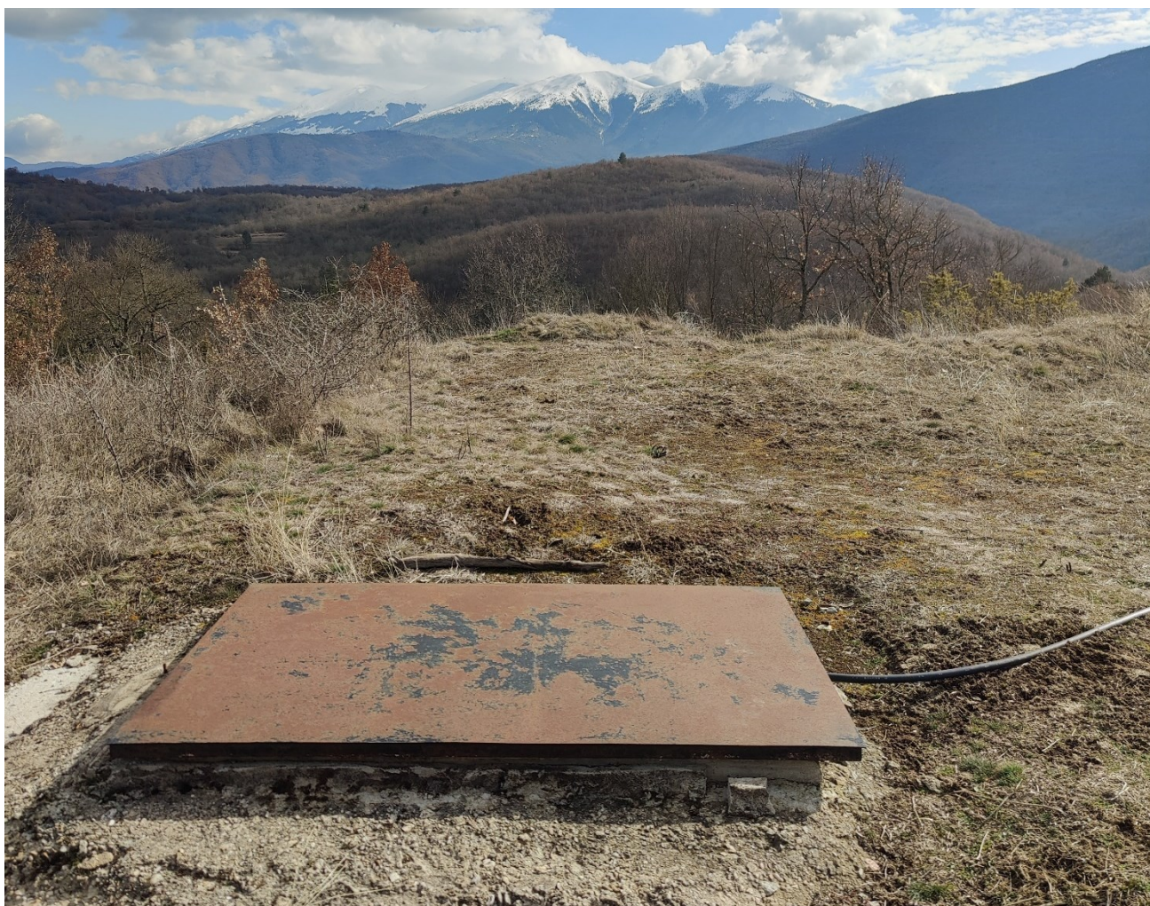
Εικόνα 8: Καταπακτή πρόσβασης στο εσωτερικό της πρώτης δεξαμενής στην κοινότητα Αχλαδιάς.
